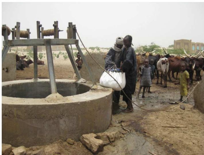
Figure 6 – Puits cimenté ouvert pour l’usage domestique et l’élevage (photo D. Djoret)
