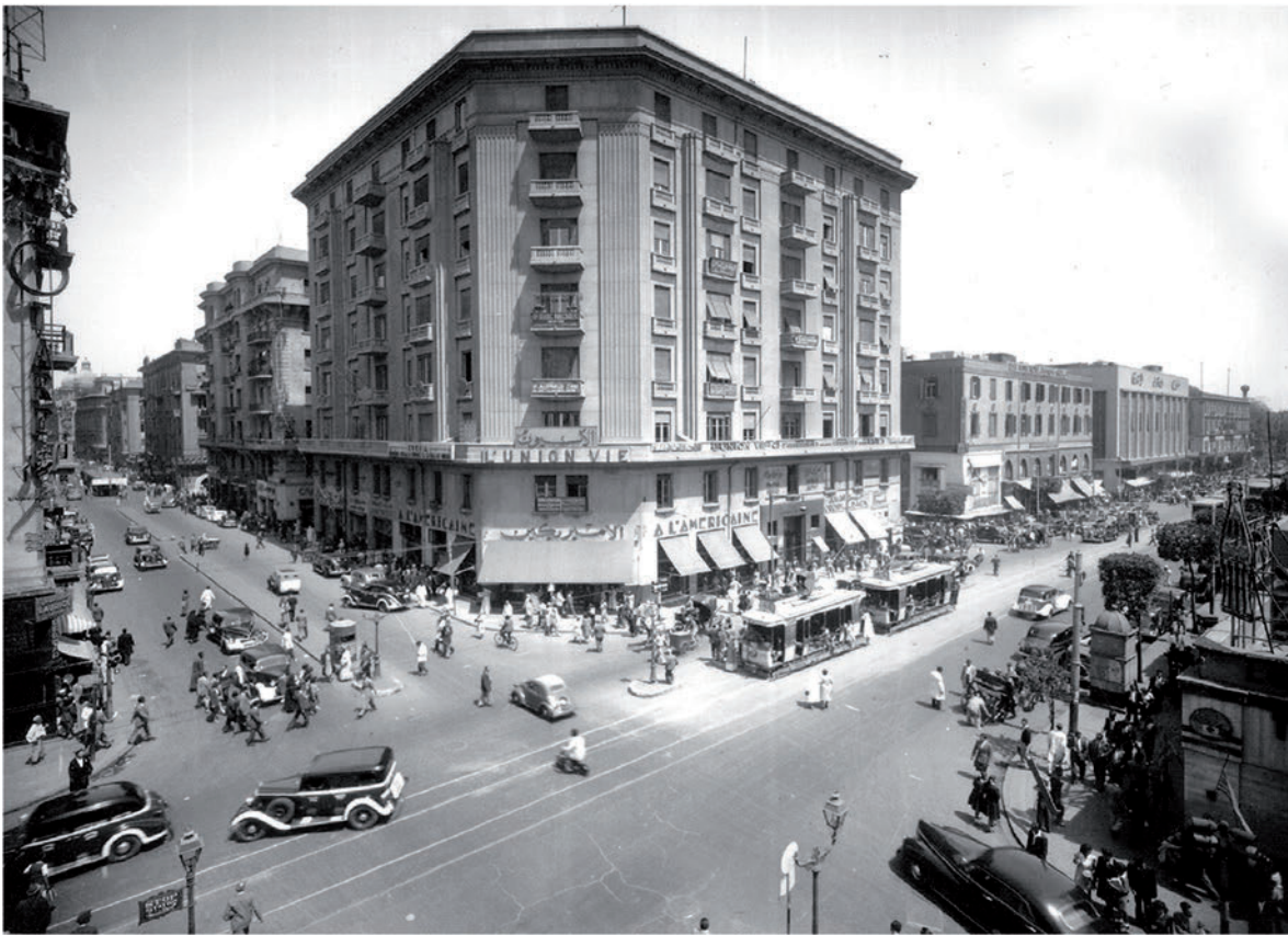
Densification du tissu urbain 173 - La rue du 26 Juillet côté ouest en 1945 Au premier plan, l'immeuble de L'Union de Paris au n° 7, architecte Georges Parcq (1932) Urban tissue densification 173 - 26 July Street west side in 1945 Foreground, L'Union de Paris building, No. 7, architect Georges Parcq (1932)
