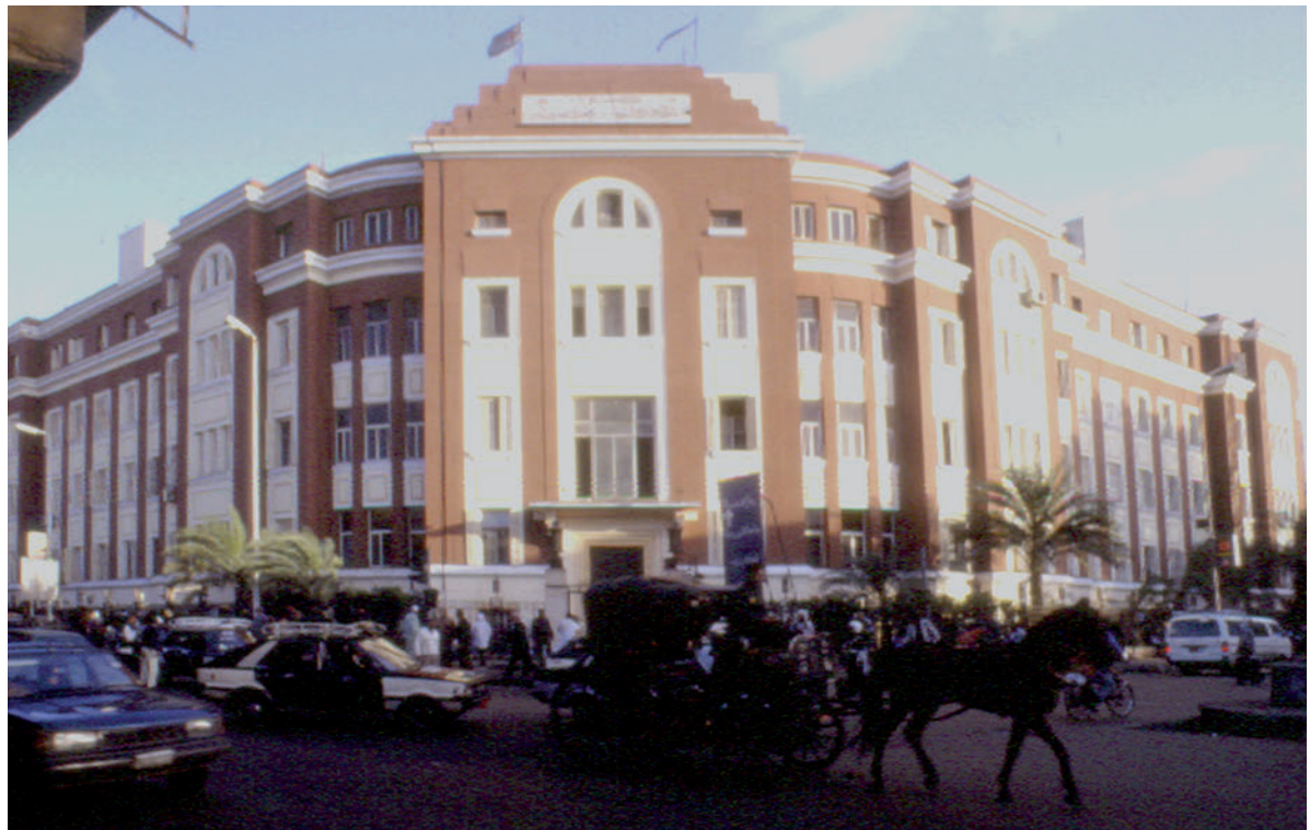
235 - L'hôpital El Galaa, angle des rues El Galaa et 26 Juillet, restauré en 2001 235 - El Galaa Hospital building, corner of al-Galaa and 26 July Streets, restored in 2001
