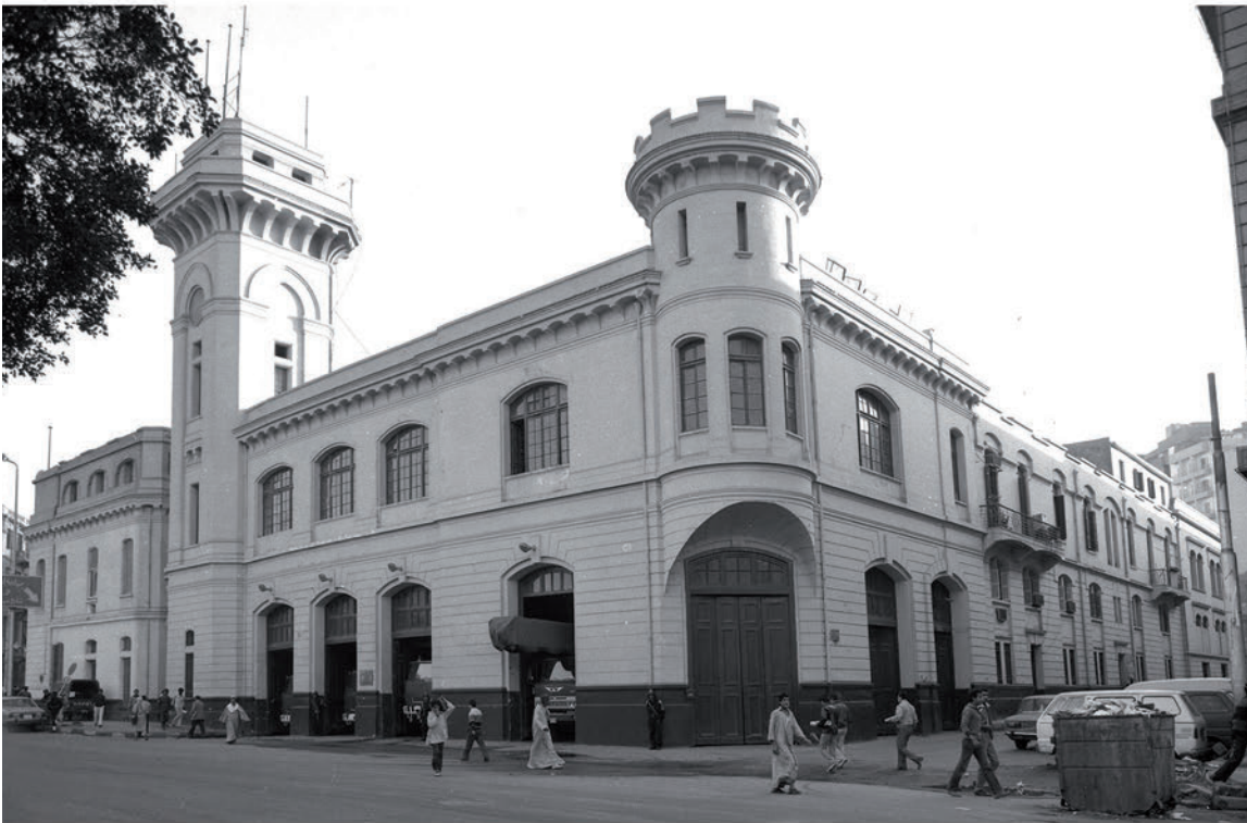
73 - Le bâtiment des pompiers, architecte Maniscalco Alfonso (1901) 73 - Fire Brigade building, architect Maniscalco Alfonso (1901)
