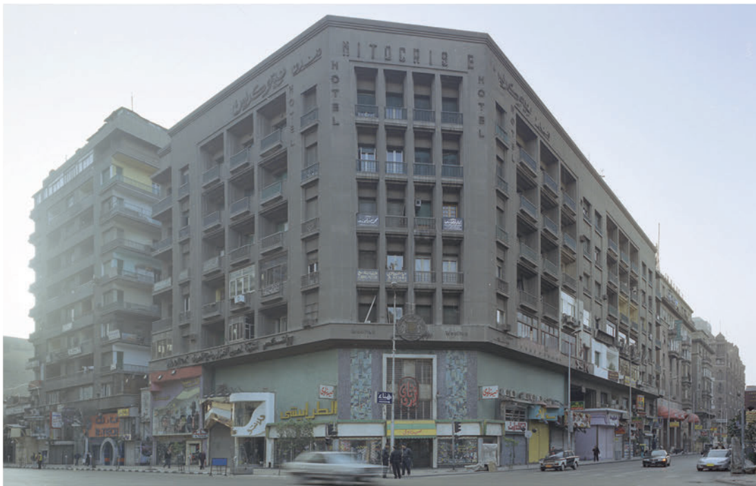
164 - L'immeuble Nitocris, angle rues Moahammad Farid (n° 171) et 26 Juillet (n° 10), architecte Antoine Selim Nahas (1948) 164 - Nitocris building, corner Mobammad Farid (No. 171) and 26 July (No. 10) Streets, architect Antoine Selim Nabas (1948)
