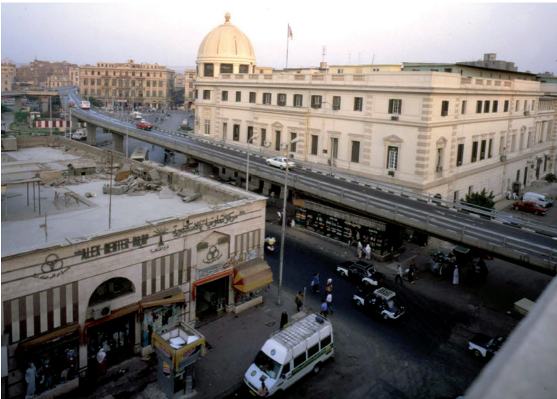
72 - La place Attaba en l'an 2000 Au premier plan, la Grande Poste (1901), devant le pont El Azhar 72 - Attaba Square in the year 2000, main Post Office (1901), in front of Al-Azhar Bridge
