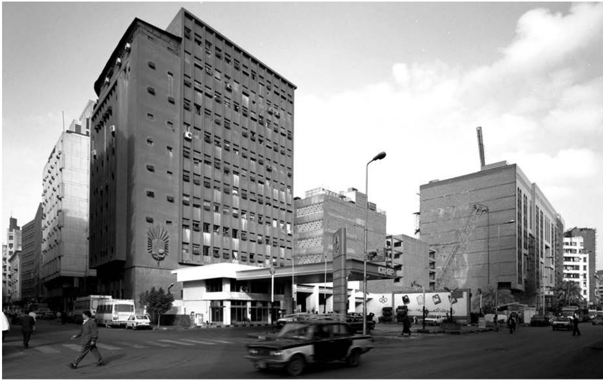
192 - La station service, rue El Goumouréya et les bâtiments du ministère des Affaires sociales, 18, rue El Alfî construits sur le site de Shephard 192 - Service station, El Goumboureya Street and the Social Affairs Ministry's buildings, 18 El Alfî Street
