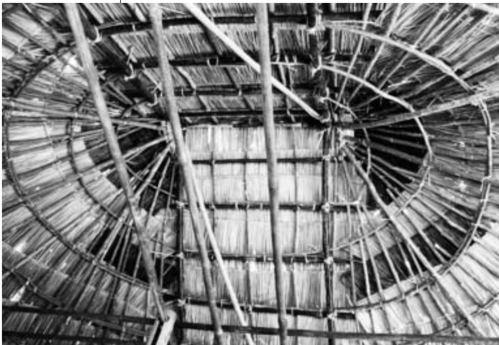
Toiture de la maison de l'essart, village de Makkoud, district de Nalae.
