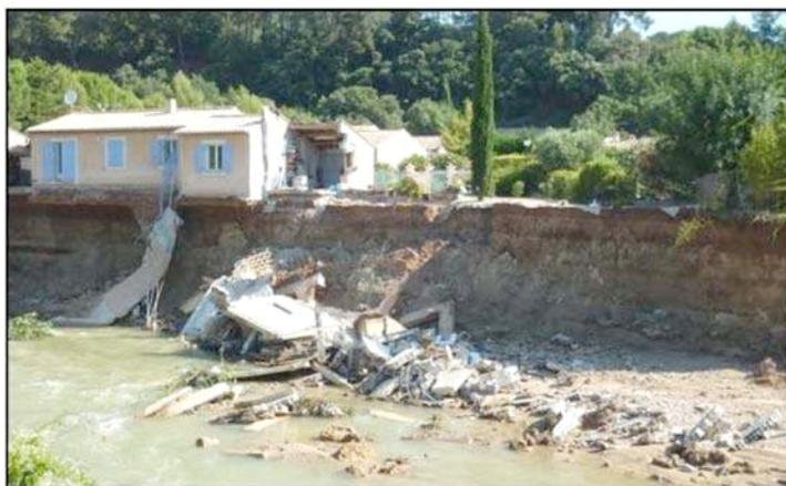
Photo 5 : La Motte - Sapement de berge et effondrement de villas au niveau du lotissement "Les Hauts de la Nartuby".
