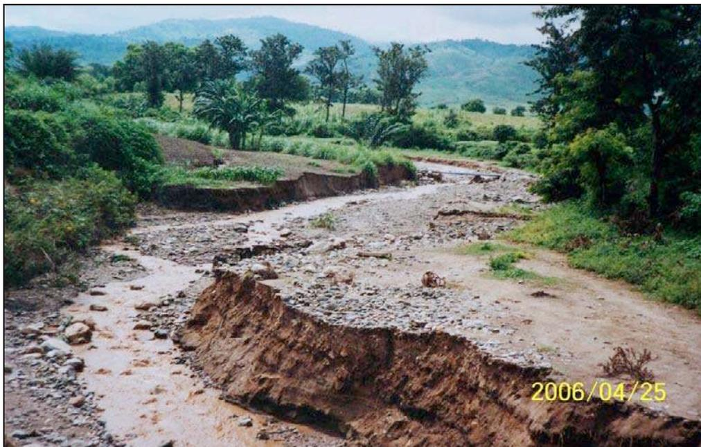
**Photo 11 : Affouillement des bas-côtés des ponts lors de la même pluie**
