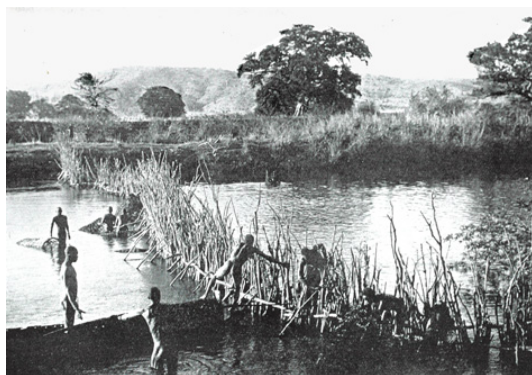
FIGURE 7 – kek en pêche sur la rivière Miriu, affluent du lac Victoria, 1927-28. Le cliché a été pris lorsque les villageois de la rive la plus proche, auxquels la moitié du barrage appartient, récoltent les poissons dans les nasses situées à gauche du kek . Ils en profitent pour effectuer quelques réparations à la structure (© E.B. Worthington)
