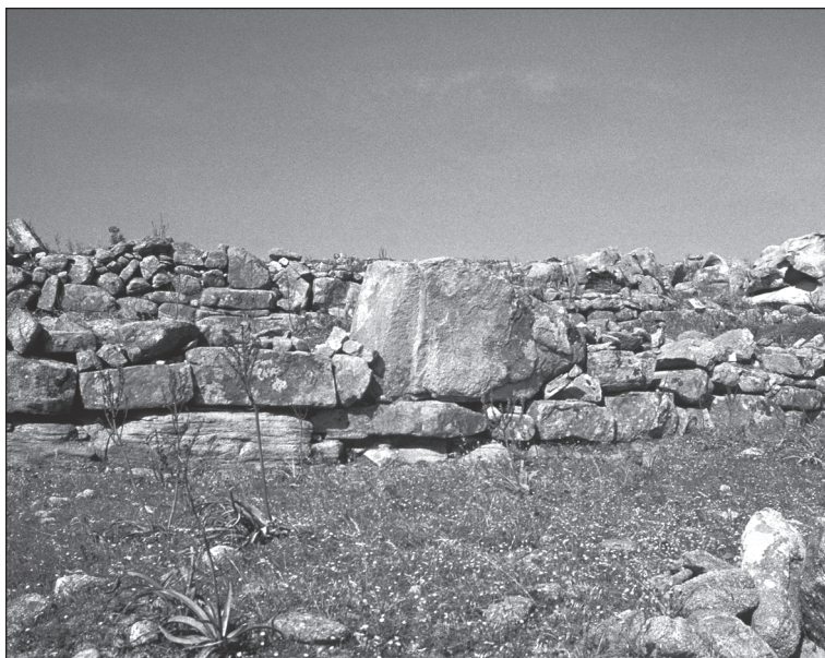
■ Photo 1 Parement intérieur d'une terrasse.
