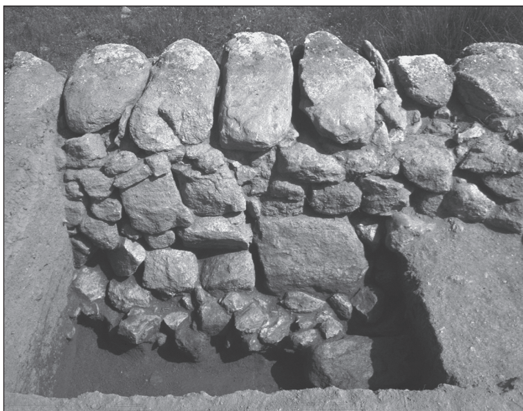
■ Photo 3 Parement extérieur d'une terrasse.
