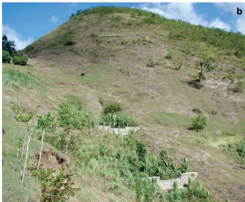
a et b : les seuils en béton retiennent en amont des sables, des matières organiques et de l'eau permettant des cultures associées intensives, et en aval, de l'eau stockée dans des cuves qui servent à l'abreuvement du bétail et à l'irrigation complémentaire, Haïti.
