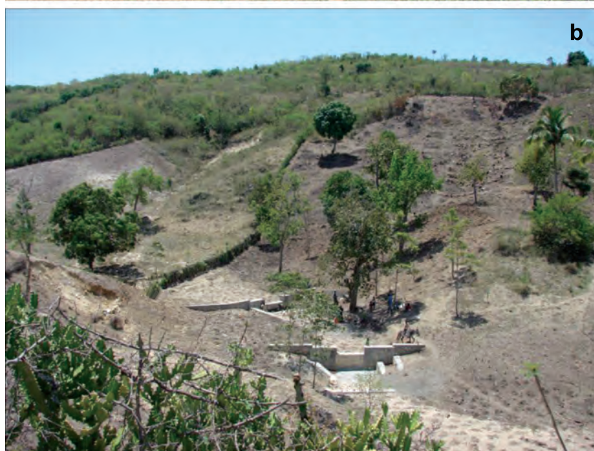
a : cuves de stockage des eaux de ruissellement des toits et des pistes : utilisations ménagères et irrigation de petits champs en aval.
