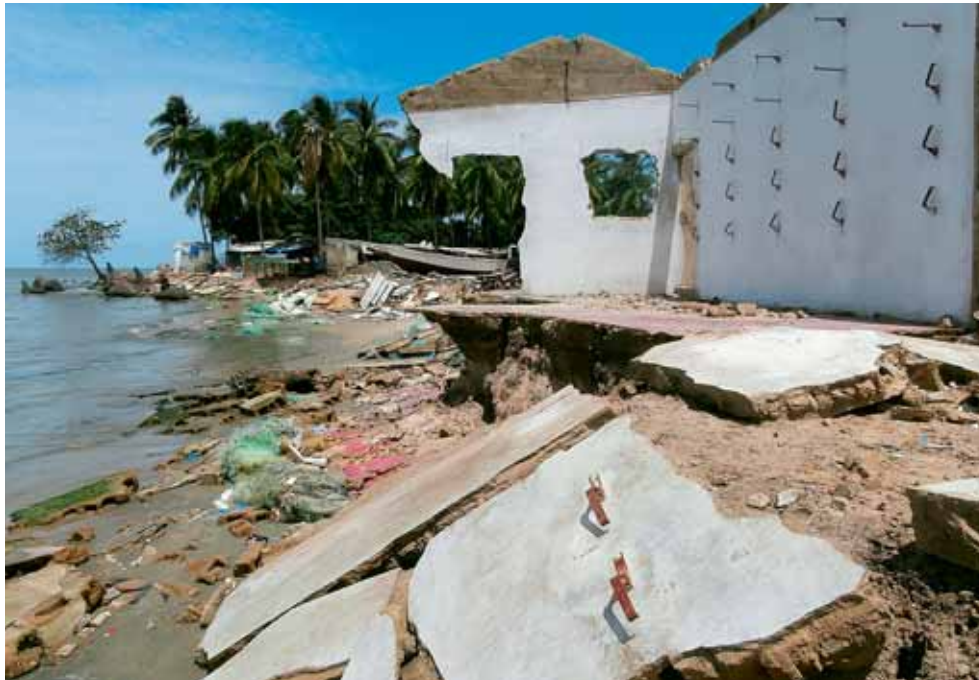
Érosion côtière au Sénégal.
