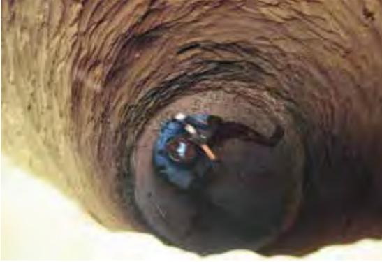
Photo 43 | Après une semaine de forage, le puits atteint une profondeur d'environ 4 m (1981).
