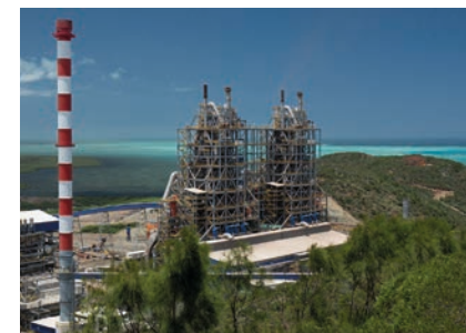
Usine de traitement du nickel, Koniambo Nickel SAS, province Nord de la Nouvelle-Calédonie. © IRD/J.-M. Boré
