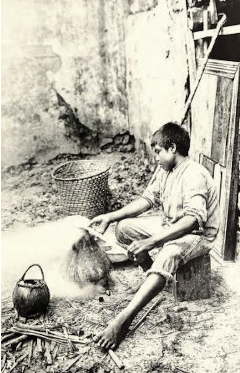
Photo 1 | Une calabasse sert à recevoir le latex d'hévéa lors de l'étape de coagulation à la fumée (embouchure de l'Amazone).
