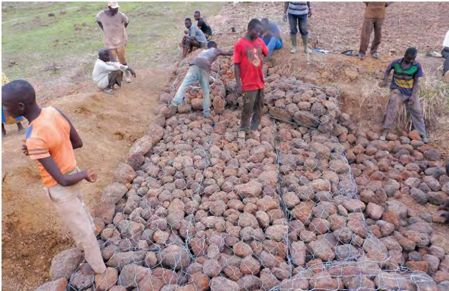
Figure 3. Le déversoir en gabions de Lofing. © IRD/G. Serpantié, juin 2018
